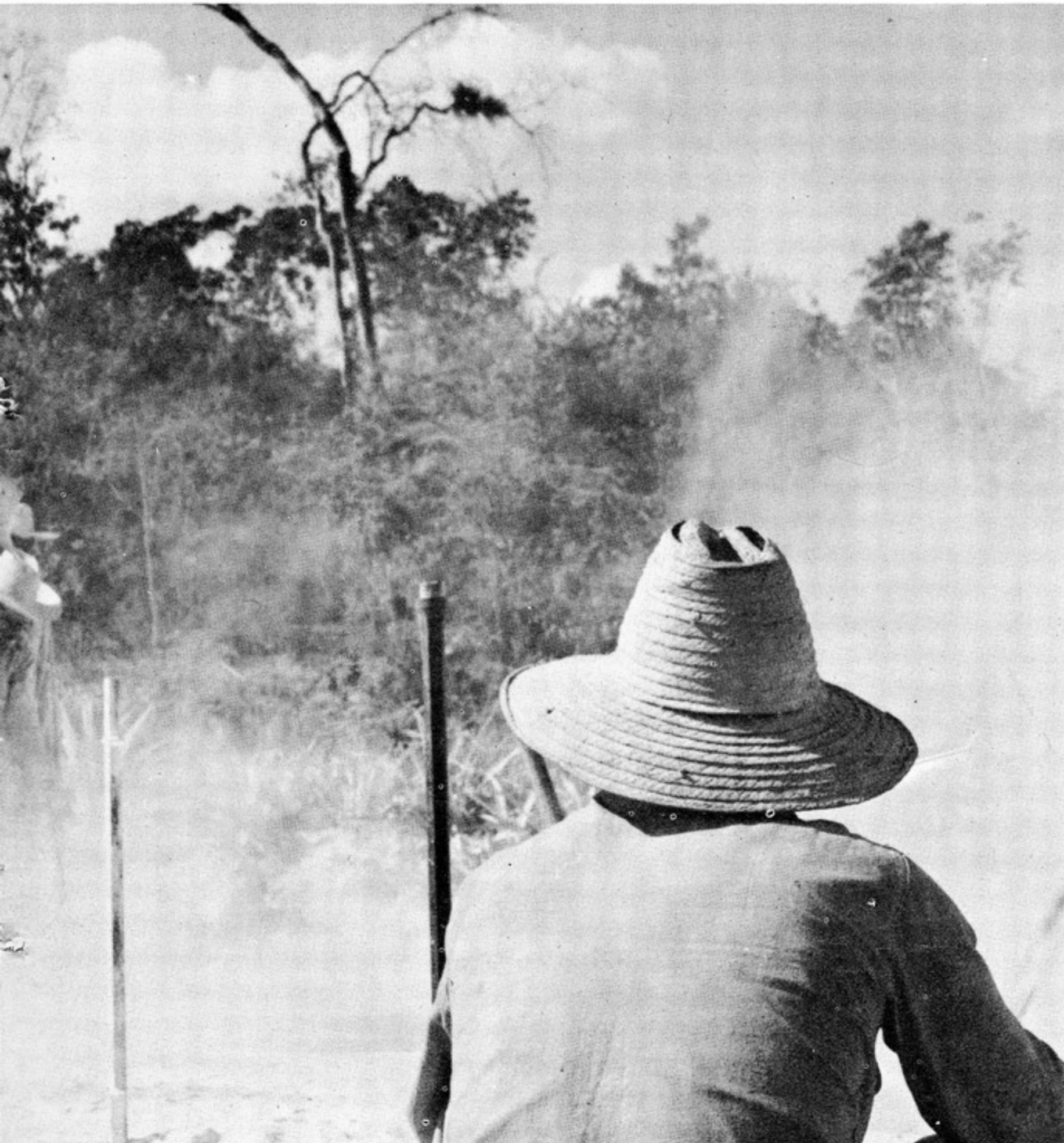
UNA COOPERATIVA MARMOLERA DE CHARCO REDONDO CORTAN BLOQUES CON MARTILLOS DE AIRE.
